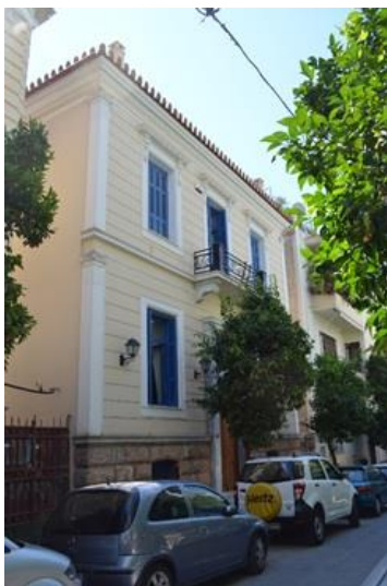
Het NIA, gevestigd aan de voet van de Akropolis.
